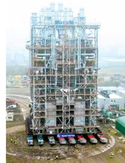
Les fourneaux ont été amenés sur le site à l'aide de transporteurs modulaires automoteurs
