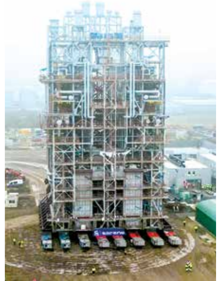
Die Öfen wurden mit selbstfahrenden modularen Transportern zum Standort transportiert
