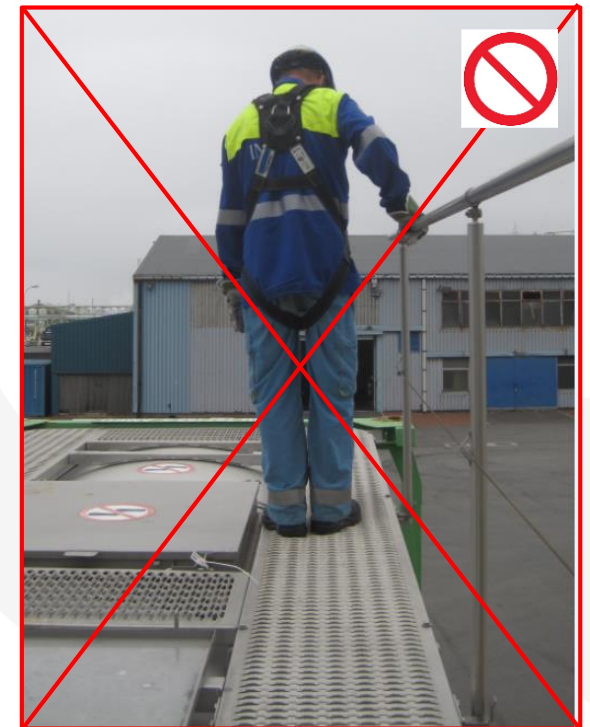
Geländer ohne befestigten Auffanggurt
