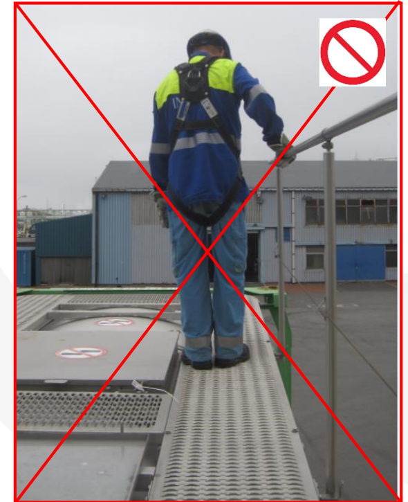
Kapaszkodó leesés elleni védelem nélkül
