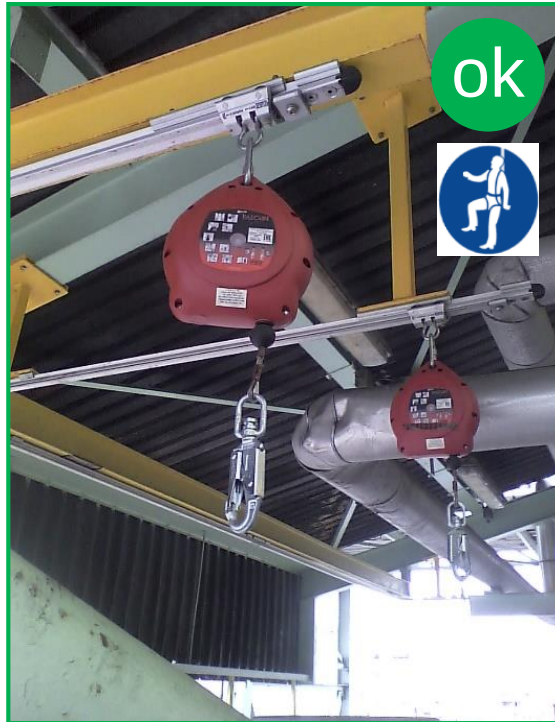
Dispozitiv de protecție contra căderii legat la centura dvs. de siguranță a corpului
