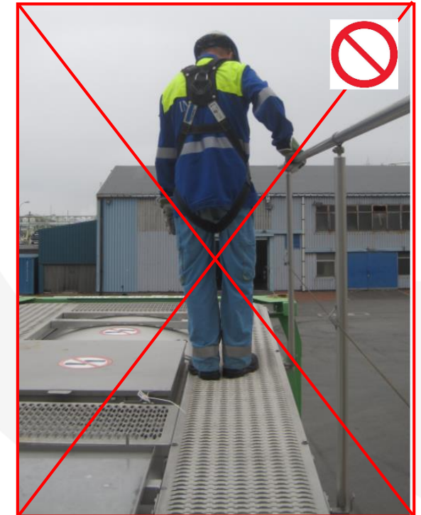
Balustradă fără protecție contra căderii
